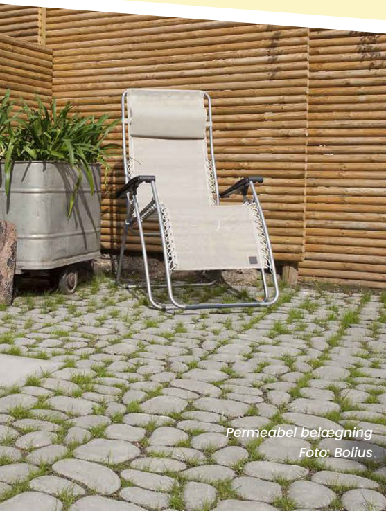
Belægning i beton eller tegl lagt med brede fuger kan også bruges som permeabel belægning Foto: Egersund Wienerberger
