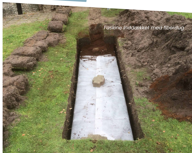
Udgravning til faskine
