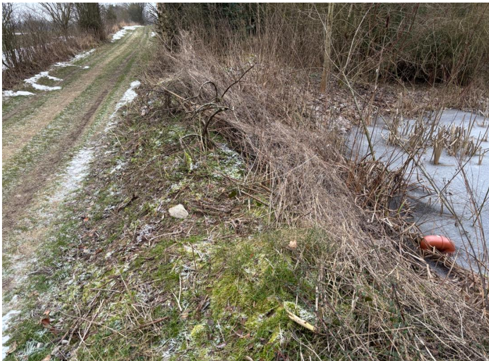
Billede 2.1. Billede taget mod øst langs vejen nord for vandhullet. Volden ønskes fjernet. Overløb fra vandhullet fører vandet i drænsystem under marken på den anden side af vejen. Vejen vil derfor ikke blive oversvømmet
