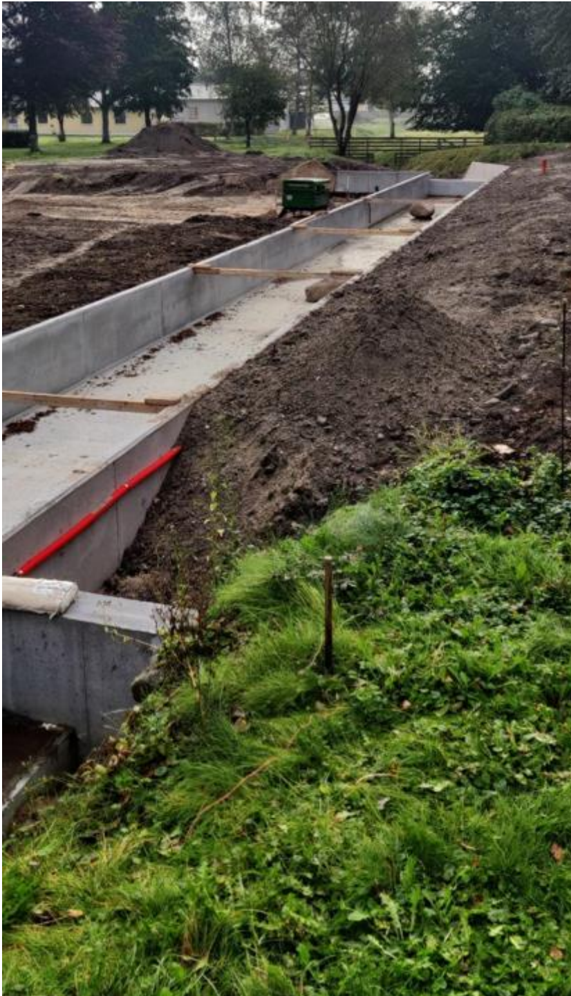
Den nye kanal set fra opstrøms side.
