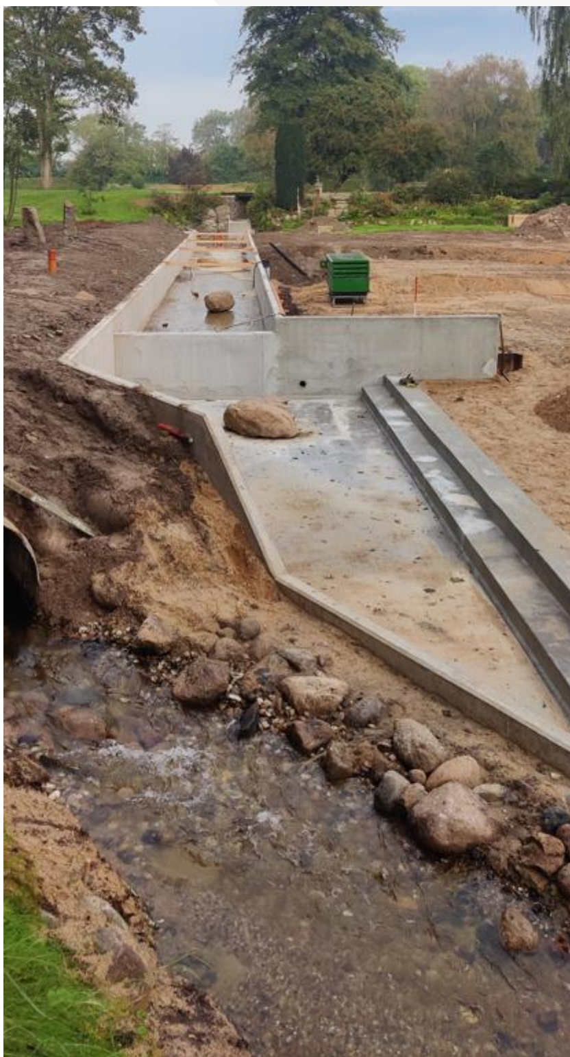
Den nybyggede kanal set i fuld længde fra nedstrøms side.
