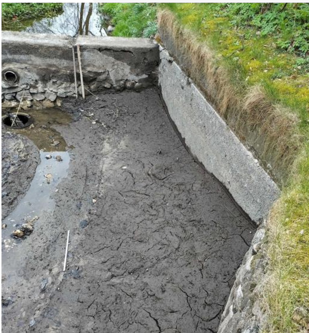
Overløbskant fra det gamle bygværk.
