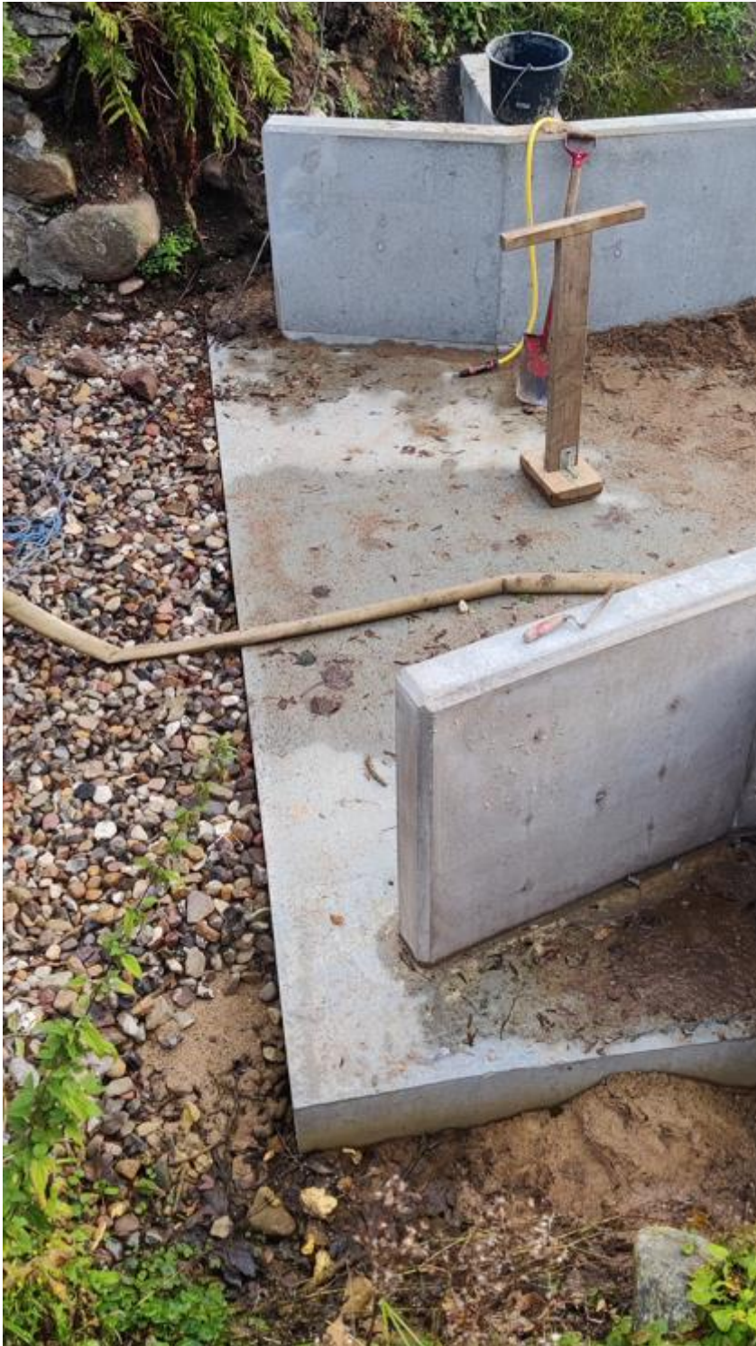
Indløb til det større betonbygværk.
