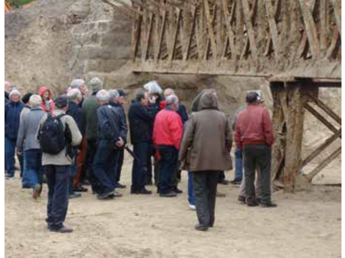
Grosses Bürgerinteresse während der Arbeiten.
