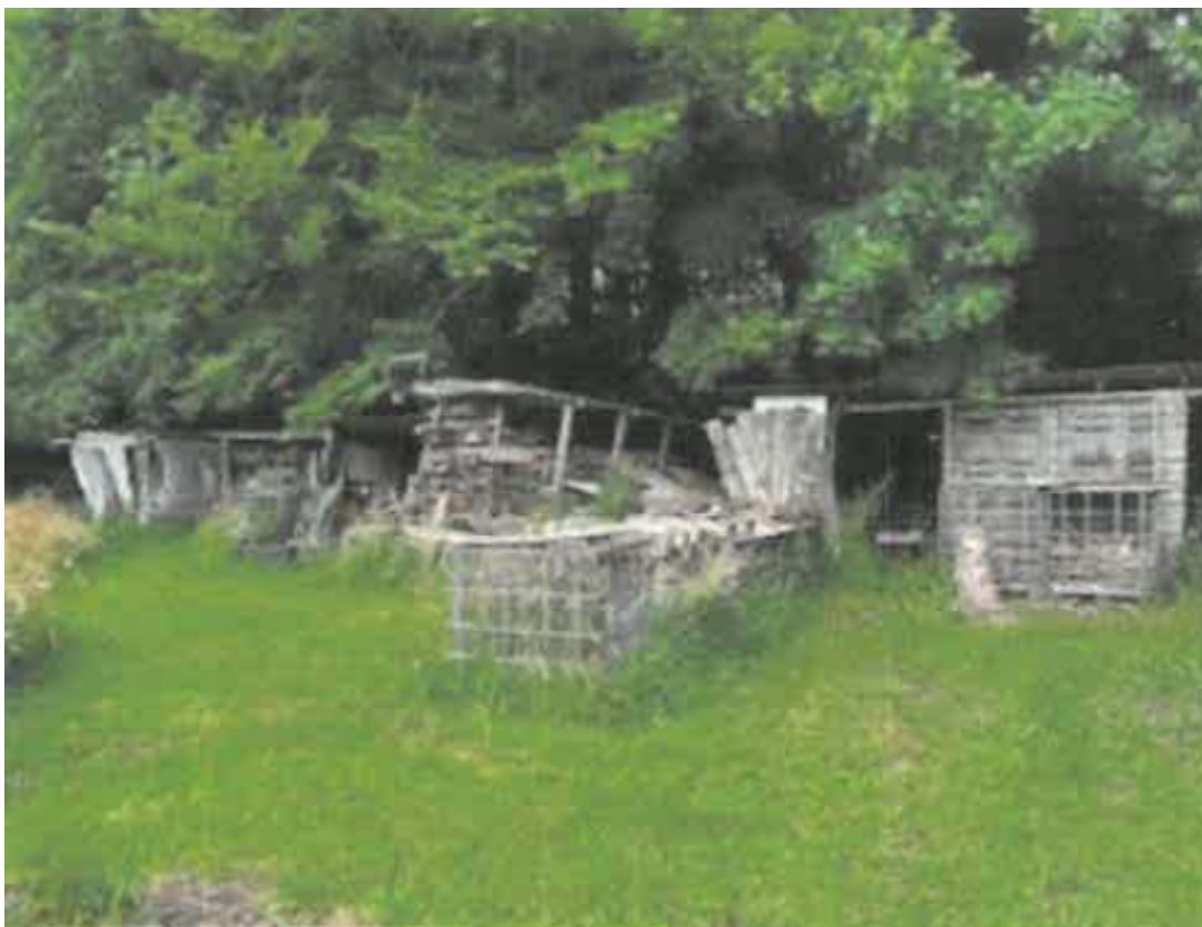
Facade af brændely på ovenstående fotot.
