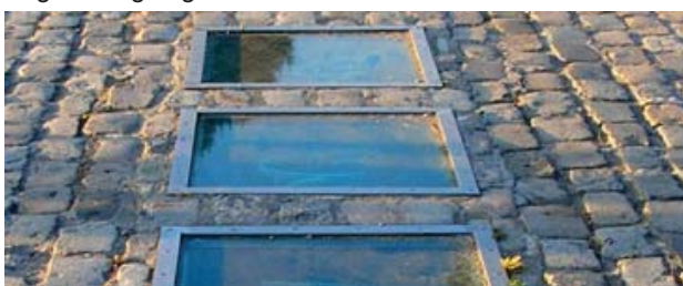
- og i belægningen
