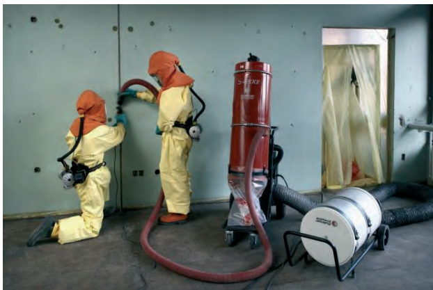
Eksempel på PCB-støvsuger med PCB-filtre
