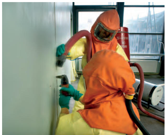
Sanering af indvendige fuger
